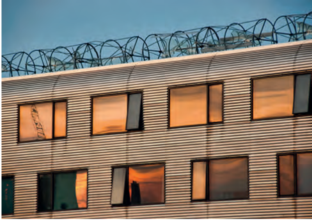
Şekil 6: Metal panel kaplama cepheden görünüm [8]
