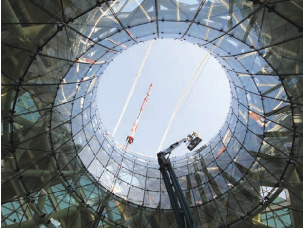
Fil Ayağı yapım aşaması
