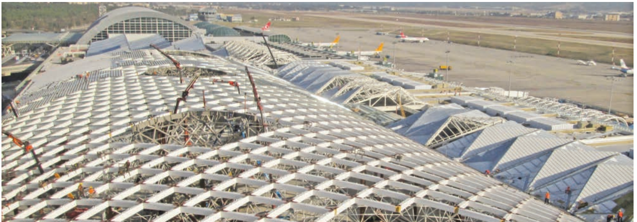
Tonoz Çatı yapım aşaması
