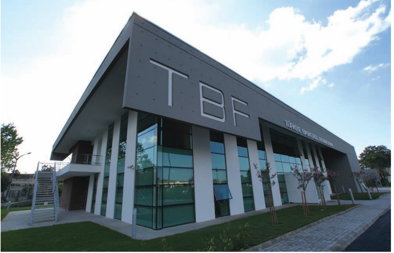
Türkiye Basketbol Federasyonu Merkez Binası
