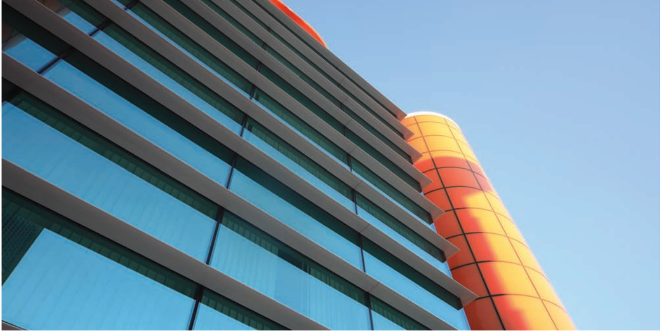
Yenigün İnşaat Yönetim Binası
