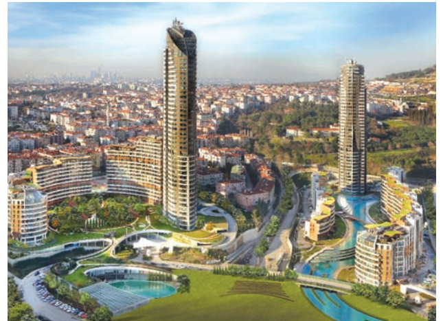
Mehpere EVRENOL'un en dikkat ettiği konulardan birisi, yüksek katlı binalarda kullanıcılara taze hava sağlanması... Bunun bir örneği de Akasya Acıbadem'in 40 katlı konut blokları olmuş...
