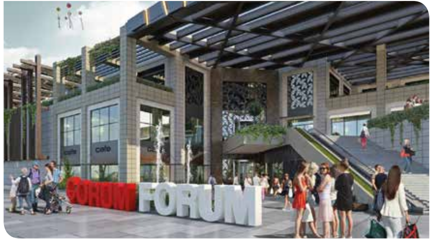
Skylight Uygulamaları - Çorum Forum AVM
