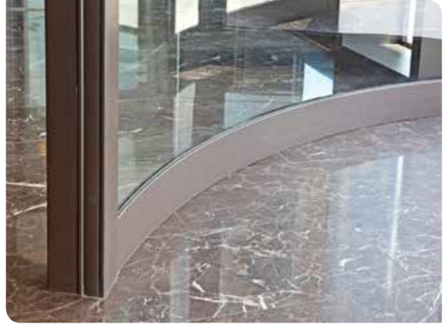
Interax Uygulamaları - Selenium Tower
