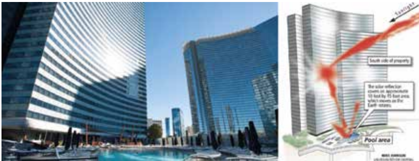
Resim 2. Vdara Hotel'in cephesindeki içbükey ayna etkisi ve cephenin ışığı odaklama davranışı [12] Kaynak: http://gizmodo.com/a-brief-history-of-buildings-that-melt-things-1247657178
