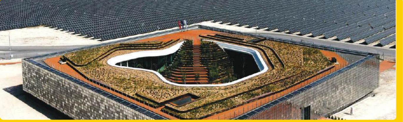
GES / Merkezi Kontrol Binası - Konya, Karapınar
